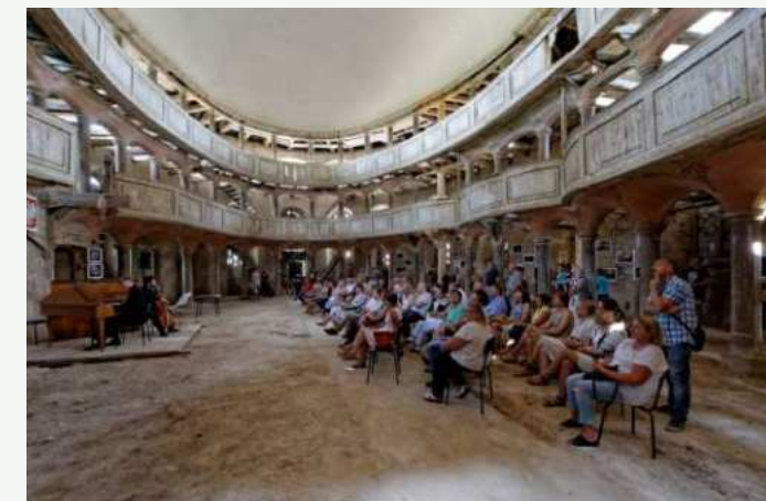
Gallerie della chiesa durante la ristrutturazione nel 2022.
